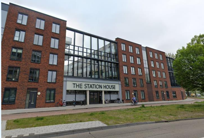
figuur 7: voorbeelden van drukke wegen met hoge geluidbelastingen met daarnaast nieuwe woningbouwontwikkelingen, die een oplossing hebben gevonden door afgeschermd balkons en stille achtergevels (bovenste figuur met nieuwbouw Gooimeerlaan) of stille binnentuinen door het dichtzetten van openingen tussen gebouwen (onderste figuur met nieuwbouw Schipholweg) (bron: Google)
